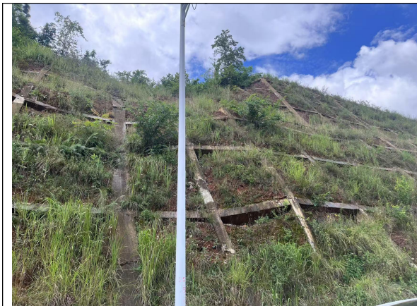
沿路边坡（已进行加固防护）
