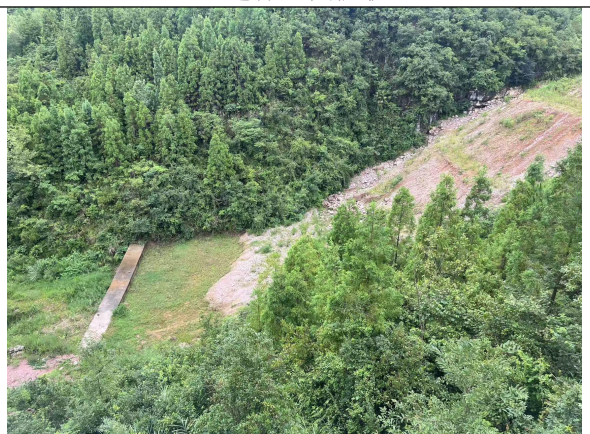
弃土场（K0+800 右侧 180m）及配套已建挡土墙
