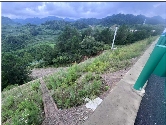
高填深挖路段（已进行坡面防护）
