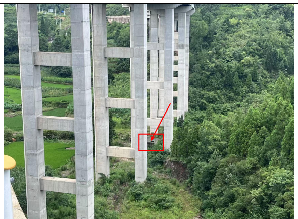
蛤蚂田大桥（K0+508）下修建的沉淀水池
