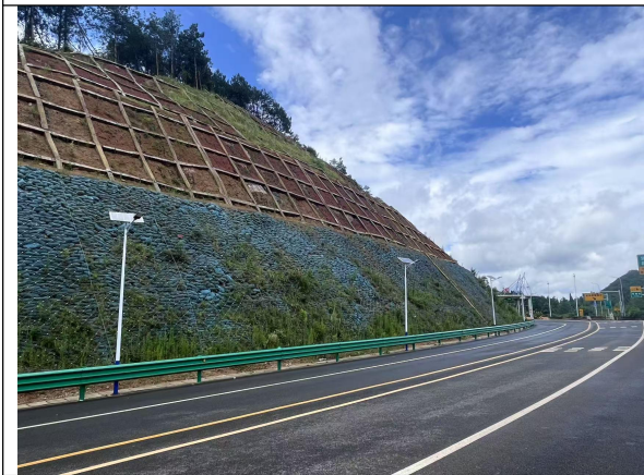
高填深挖路段（已进行坡面防护）
