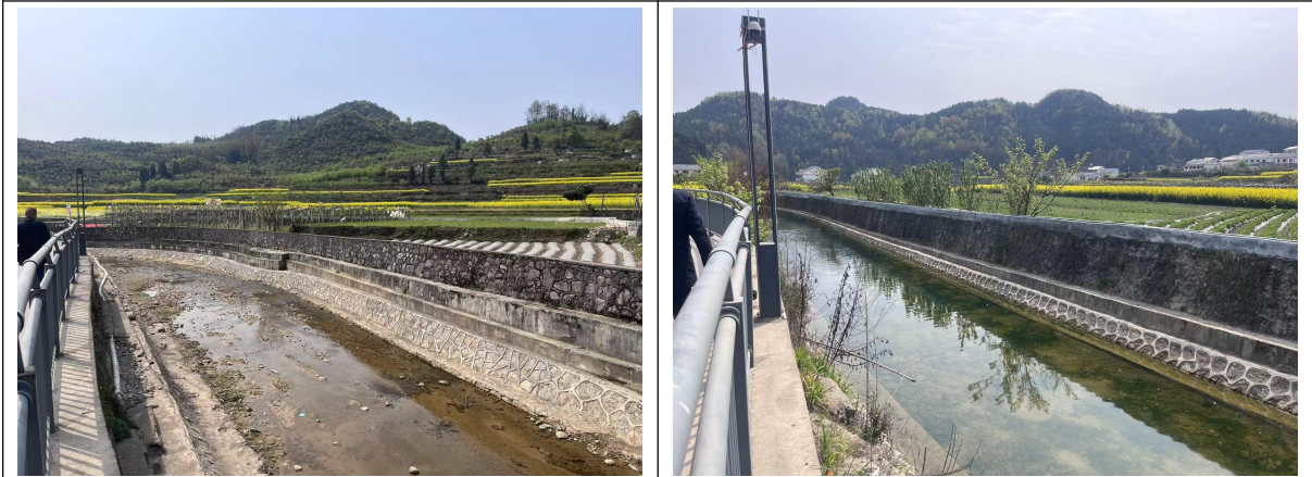
项目部分现状照片
