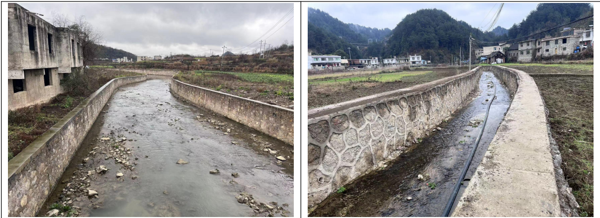
项目部分现状照片
